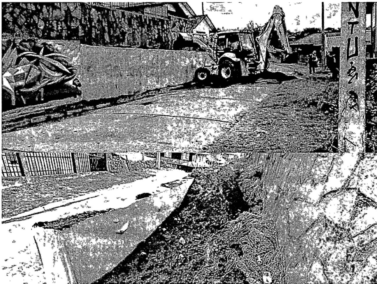
Imagen 6: Aplicación de material estabilizado para relleno de muro, PENDIENTE compactación de material colocado.
