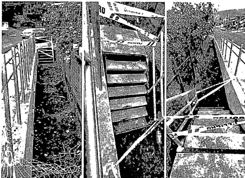
Imagen 4: Instalación de escalera de acceso al costado de muro, con respectiva aseo general de sector intervenido.
