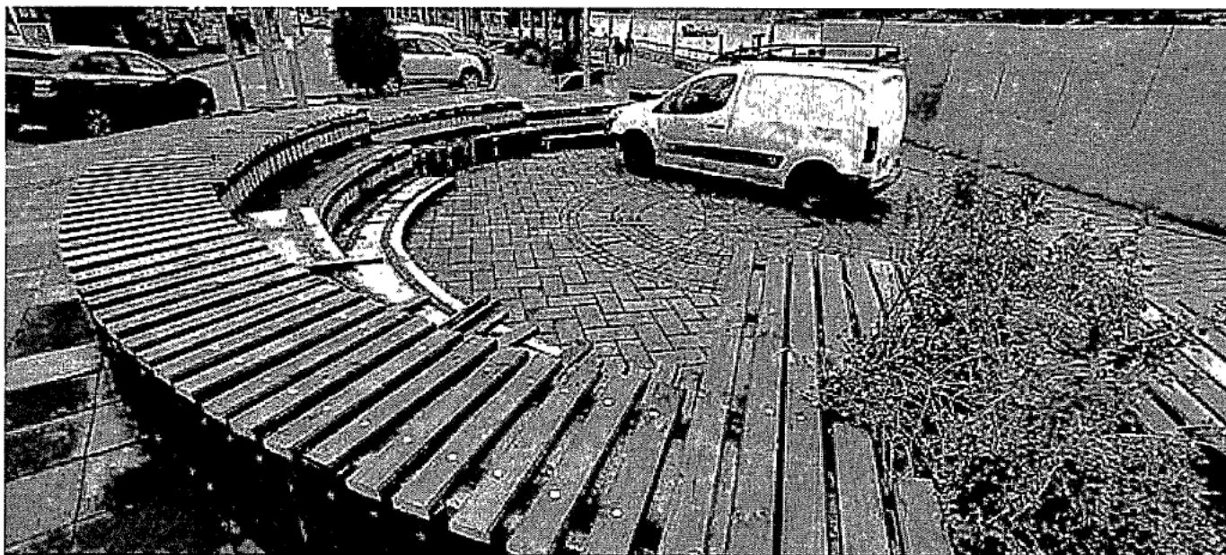
Imagen 1: Instalación parcial de entablado de pino 2x4" en cara horizontal para banca continua sobre estructura de fijación existente (reacondicionada).
