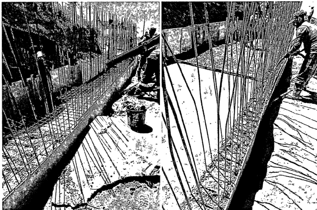
Imagen 5: Instalación de malla de zapata en perfiles fe12 y distanciamiento cada 15 cm.
