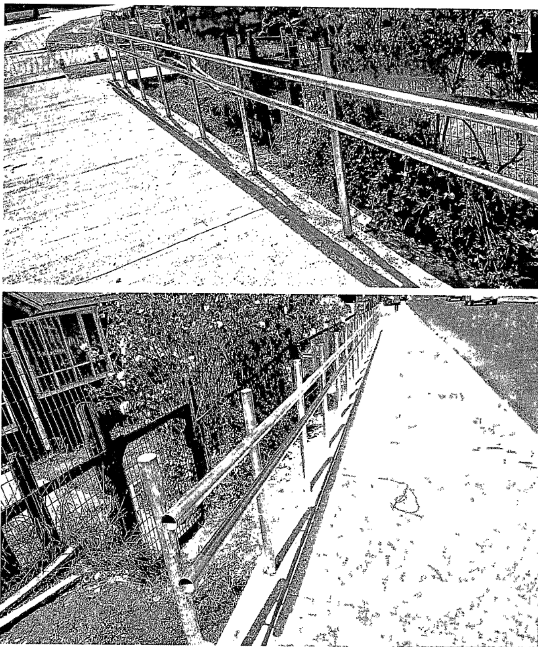
Imagen 2: Instalación de baranda peatonal sobre coronación de muro de contención, en largo total de 15 ml.
