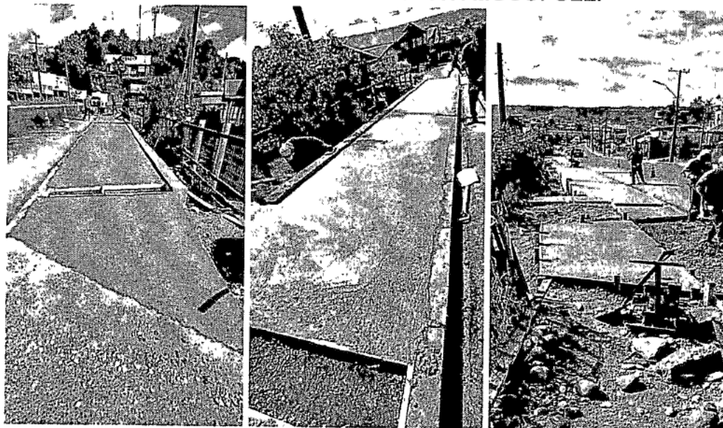
Imagen 9: Hormigón G-25 para vereda proyectada y acceso vehicular en avenida Mocopulli.
