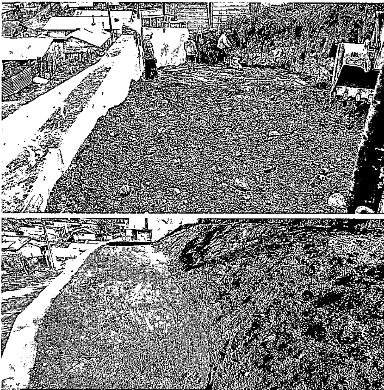
Imagen 10: Relleno de muro con respectiva compactación mediante el uso de placa compactadora.
