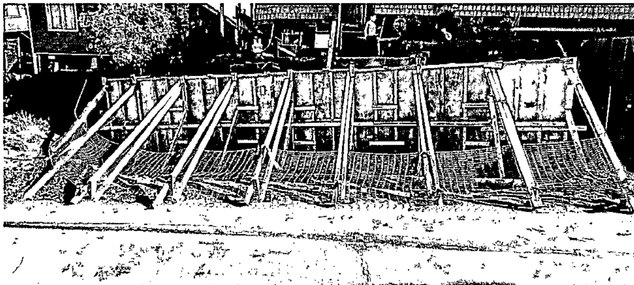
Imagen 11: Instalación de moldaje en pantalla de muro (9,2 ml).
