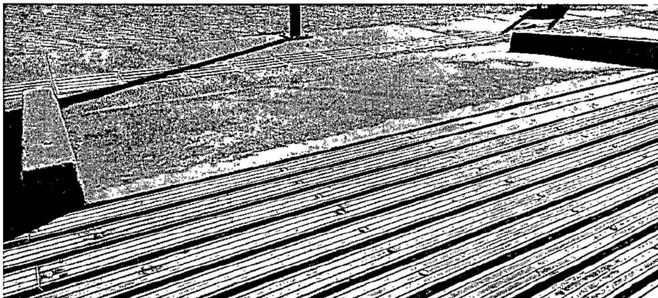
Imagen 5: Desbaste de borde en rampa de acceso, quedando a nivel de entablado de piso instalado.
